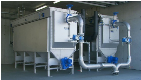
Figuur 9 Warmtewisselaars buiten de rioolbuis
